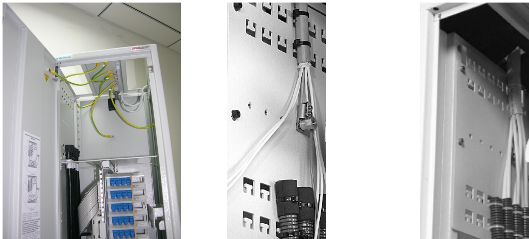
Fig. 12: modulo di sfiocamento cavi
