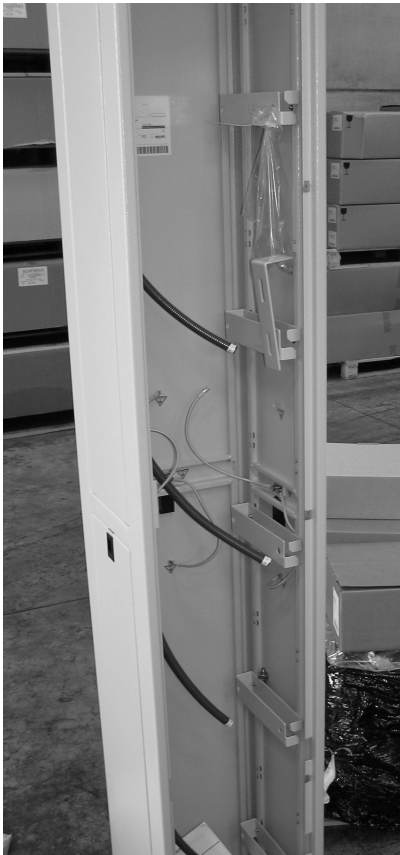
Fig. 6: staffa metallica di gestione bretelle.
