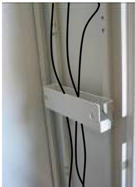
Fig. 11: percorso interno (parete destra del telaio) delle bretelle
